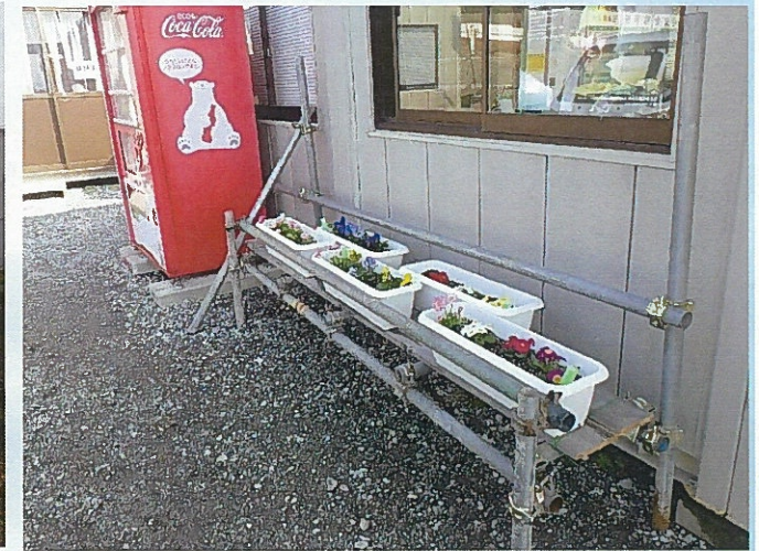
現場事務所前にプランター花も設置 近くに商店等がないため 飲み物の自動販売機の設置
