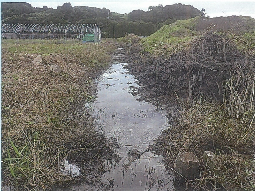
既設の水路が残っており軟弱地盤となっており、捨石（石）を入れて排水及び地盤の確保
