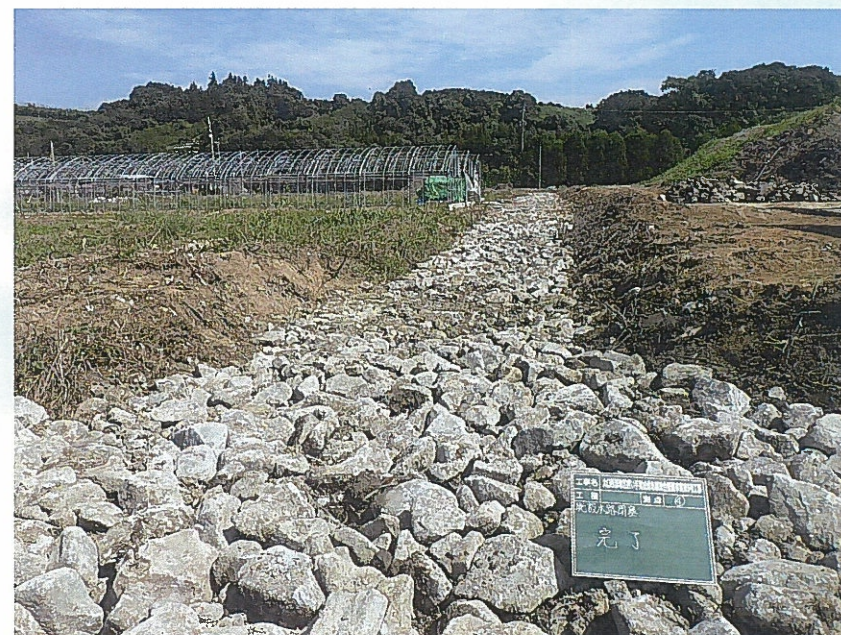
1.8mの赤白ポールが入ってしまうぐらい軟弱地盤の為スケルトンで振るい分けた石などを入れ込み排水及び地盤の確保を行いました。
