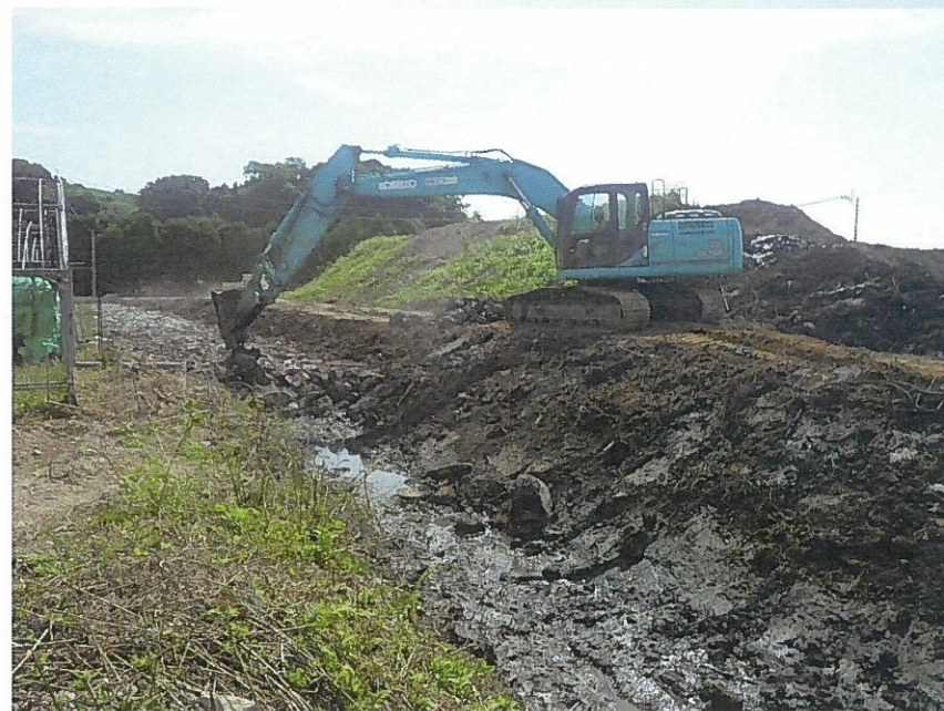
1.8mの赤白ポールが入ってしまうぐらい軟弱地盤の為スケルトンで振るい分けた石などを入れ込み排水及び地盤の確保を行いました。
