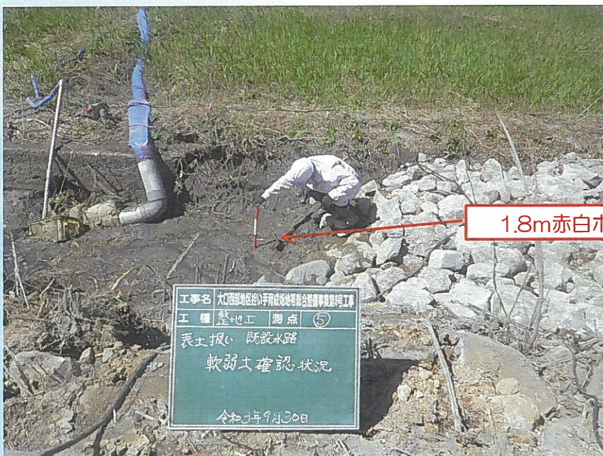
既設の水路が残っており軟弱地盤となっており、捨石（石）を入れて排水及び地盤の確保
